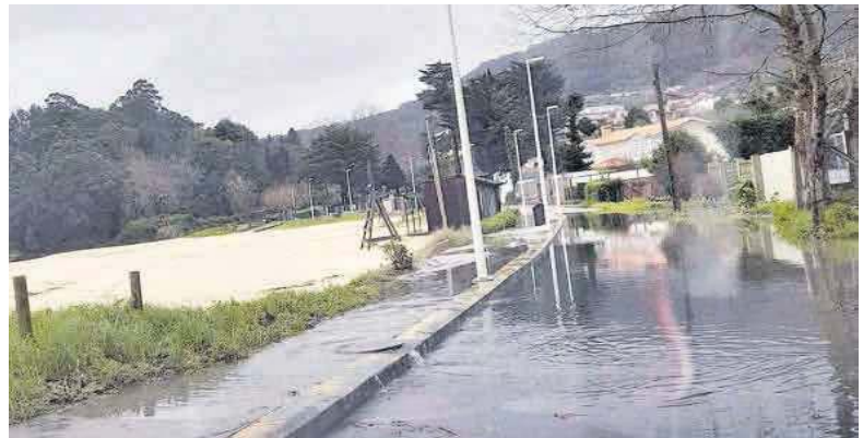
El vial de Portomaior, en enero de 2023, completamente anegado por el agua. | Santos Álvarez
