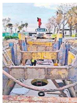
La obra del tanque de tormentas.
