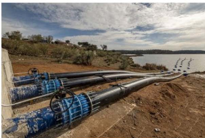
Obras de Interconexión de los embalses de La Colada y Sierra Boyera, en Córdoba. CONFEDERACIÓN HIDROGRÁFICA DEL GUADIANA 08/2/2023
